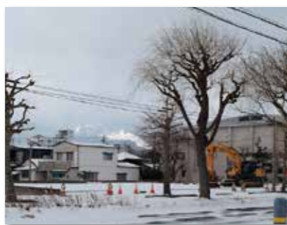
解体終了後の跡地
