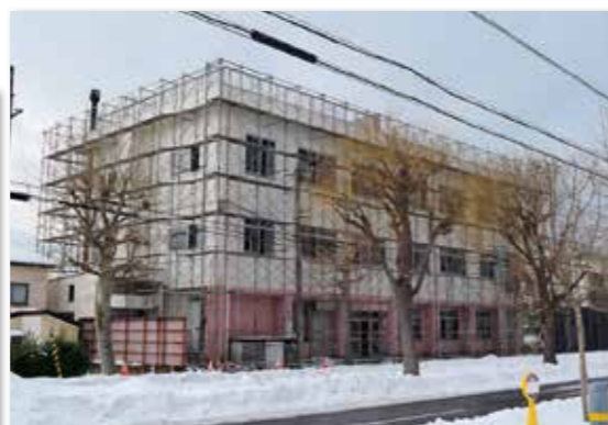
解体工事が行われた旧本店
