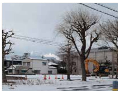
解体終了後の跡地
