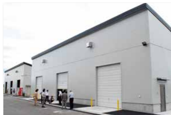
CE資材倉庫の完成検査を行う常勤役員
