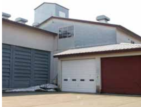
▲格納整備に利用される久喜沢ライスセンター
